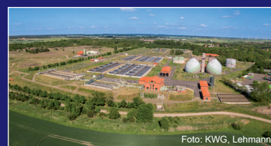
► Čistírna odpadních vod Gerwisch
